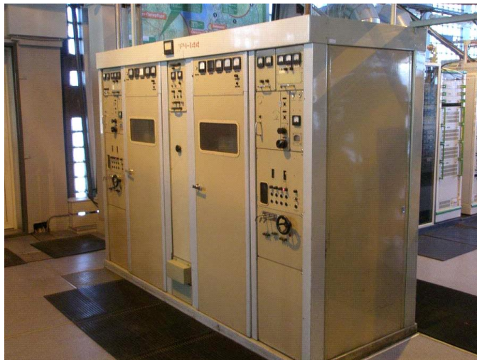
Ламповый ТВ передатчик "Игла" ( P = 1 \text{ кВт} )
