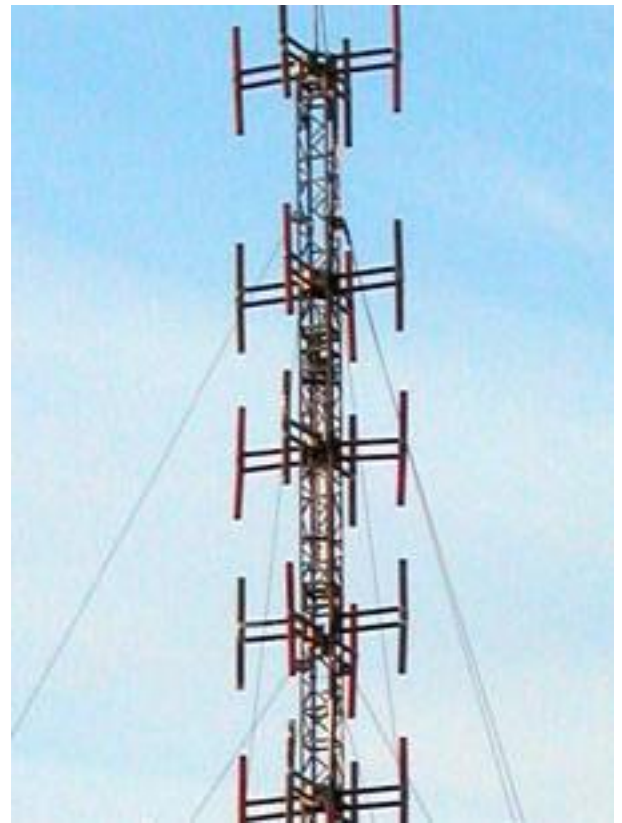
Система вертикально расположенных разрезных вибраторов
