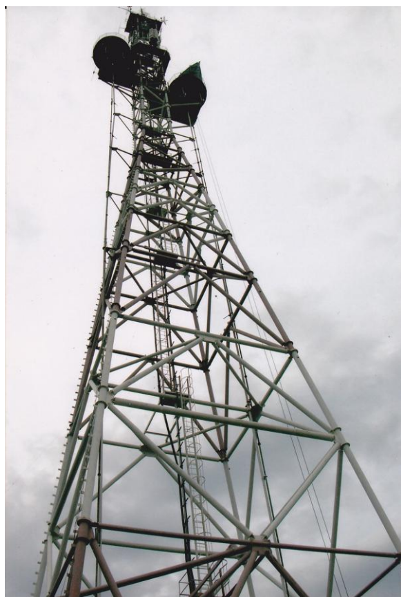
Антенномачтовое сооружение РТС
